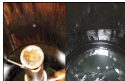
Depósito contaminado Limpio
